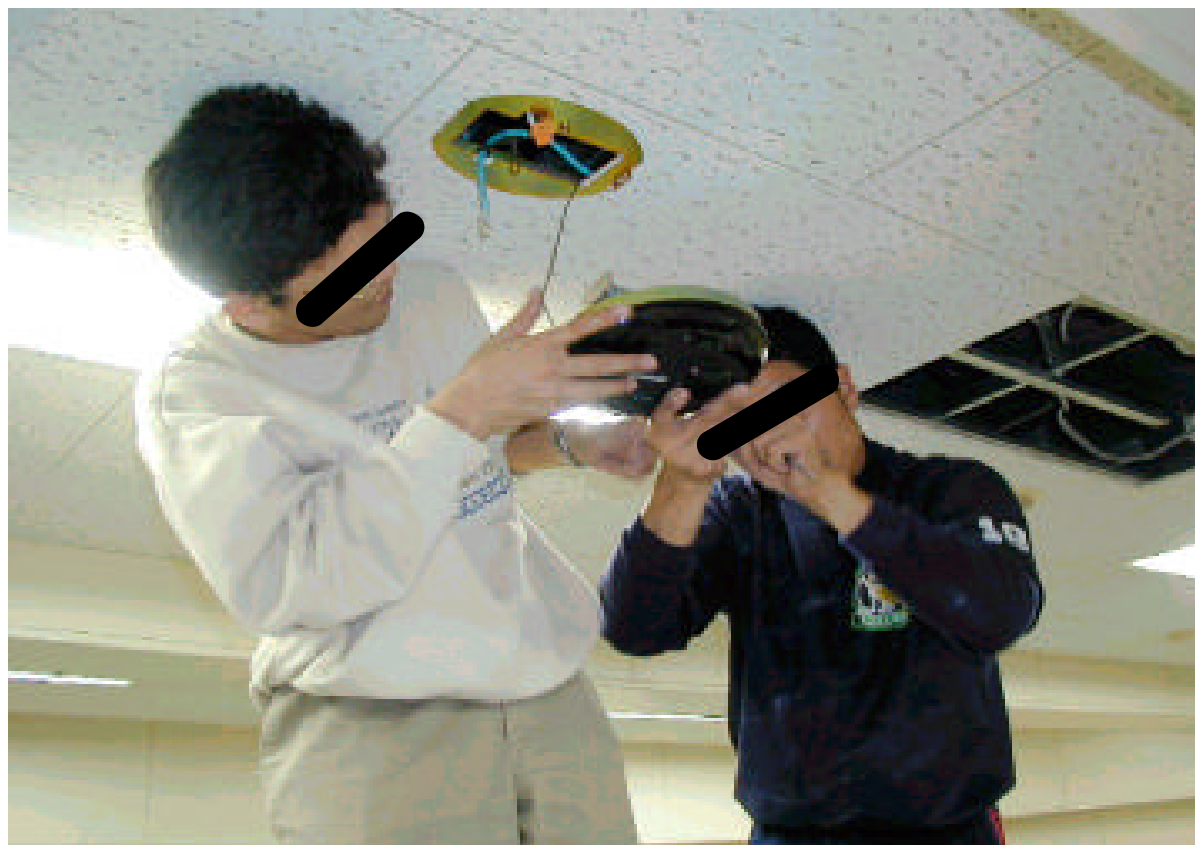
先生による光無線HUBの取り付け風景
